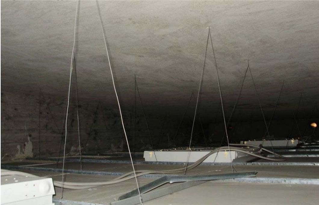
(3.1.5 F) Il controsoffitto a cui è direttamente collegata l'apparecchiatura di illuminazione non appare idoneo a sostenerne il carico
